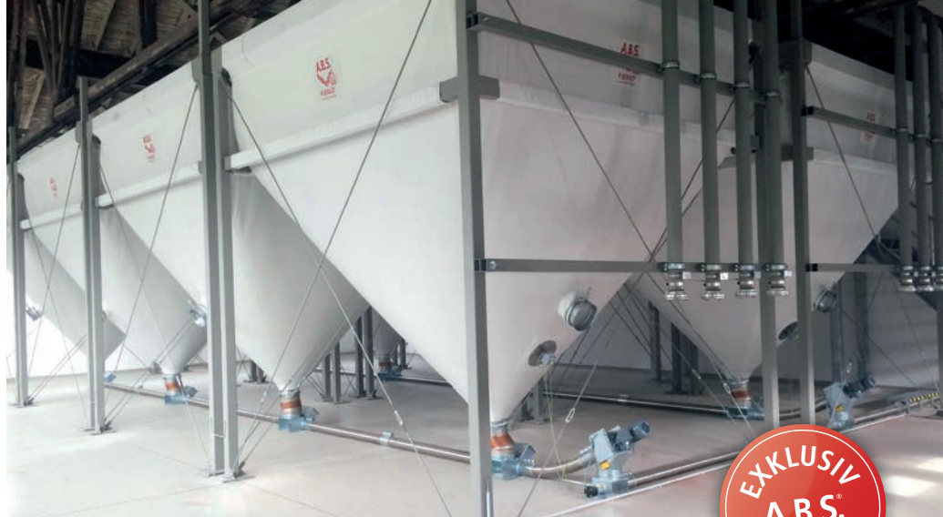
8 Flexilo MAXI 36/36, Lagermenge: ca. 200 m 3 / 130 t, Heizkesselleistung: 1000 kW
