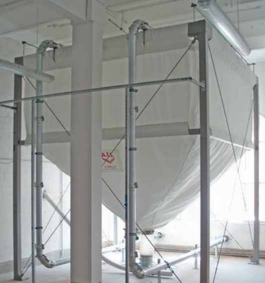
Flexilo MAXI 33/34, Lagermenge: ca. 24,8 m 3 / 16,2 t, Heizkesselleistung: 48 kW
