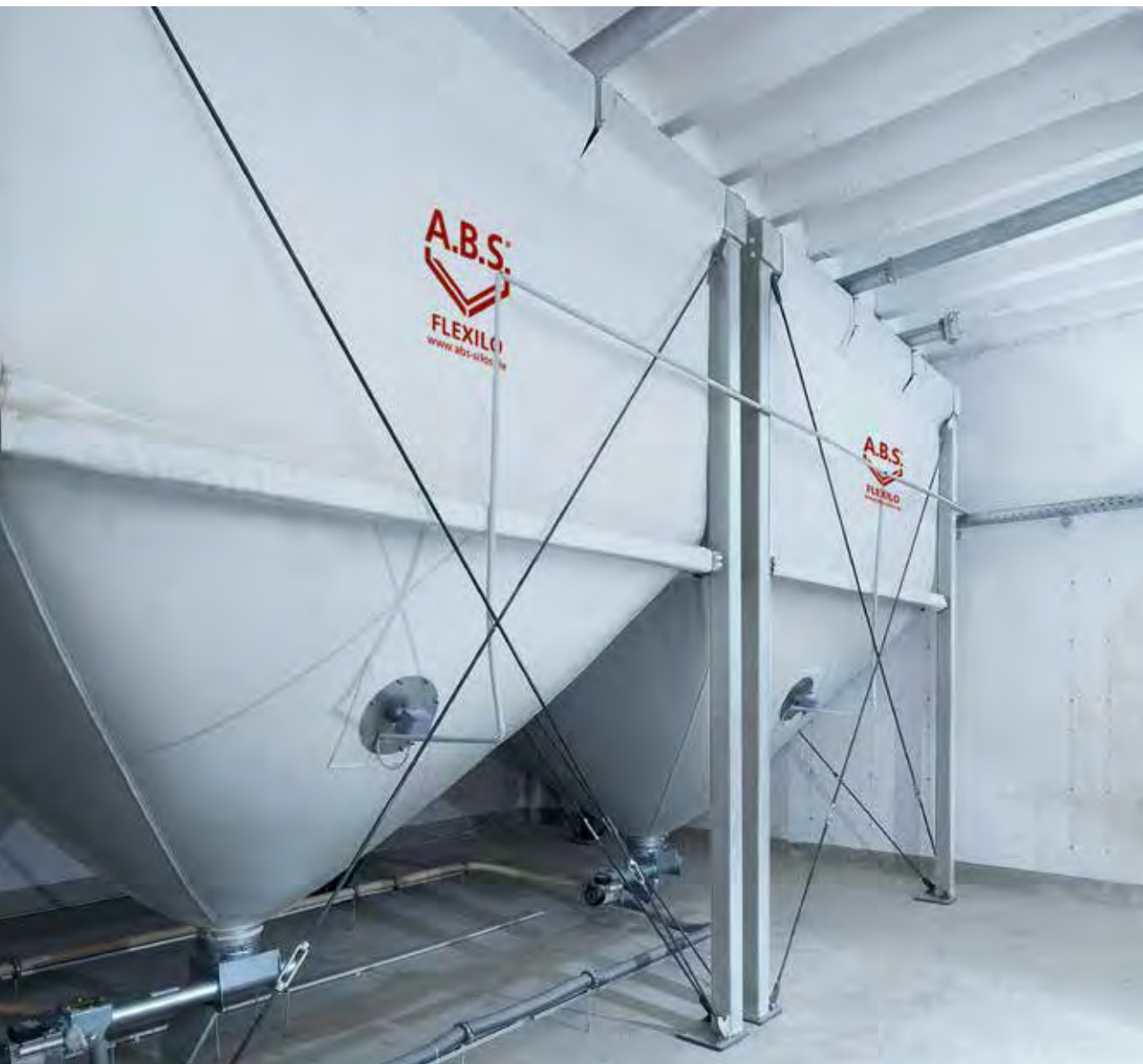
Lagerkaskade aus Flexilo® MAXI (30 t) für 100 kW Pelletheizanlage in einer Schule
