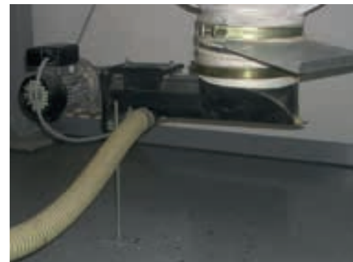
Spiralförderanlage eines Kesselherstellers
