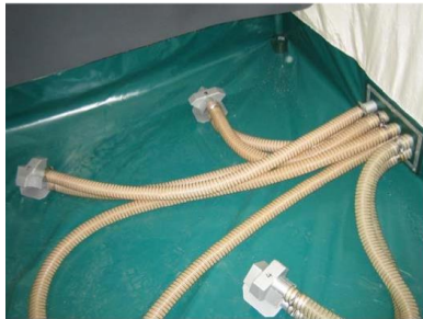
Saugsondenverlegung
