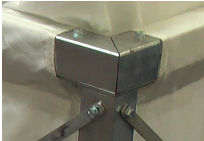
Details der Eckverschraubung
