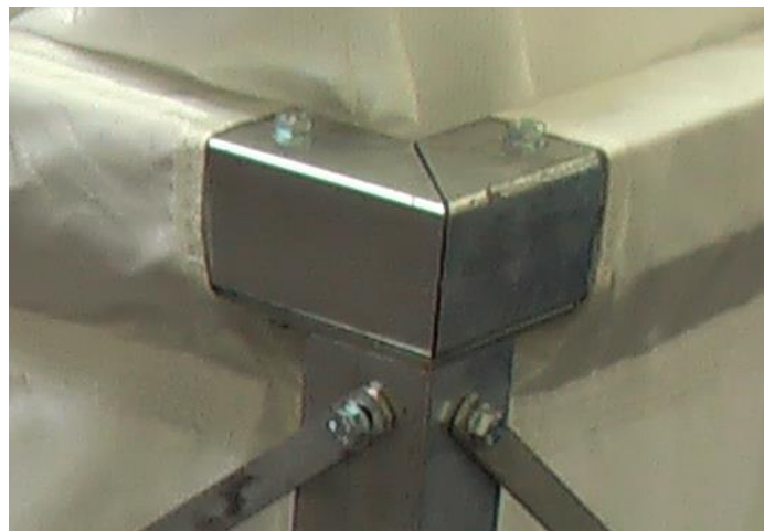
Details der Eckverschraubung
