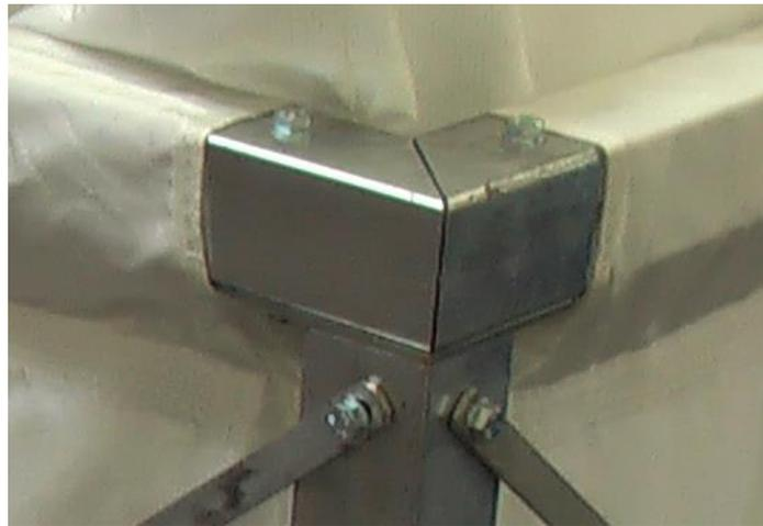
Details der Eckverschraubung
