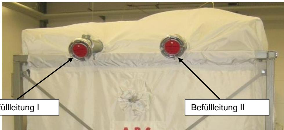
Flexilo® für Holzpellets mit zwei Befüllstutzen
