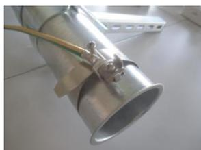
Anbringung der Erdungsschelle an dem Befüllrohr
