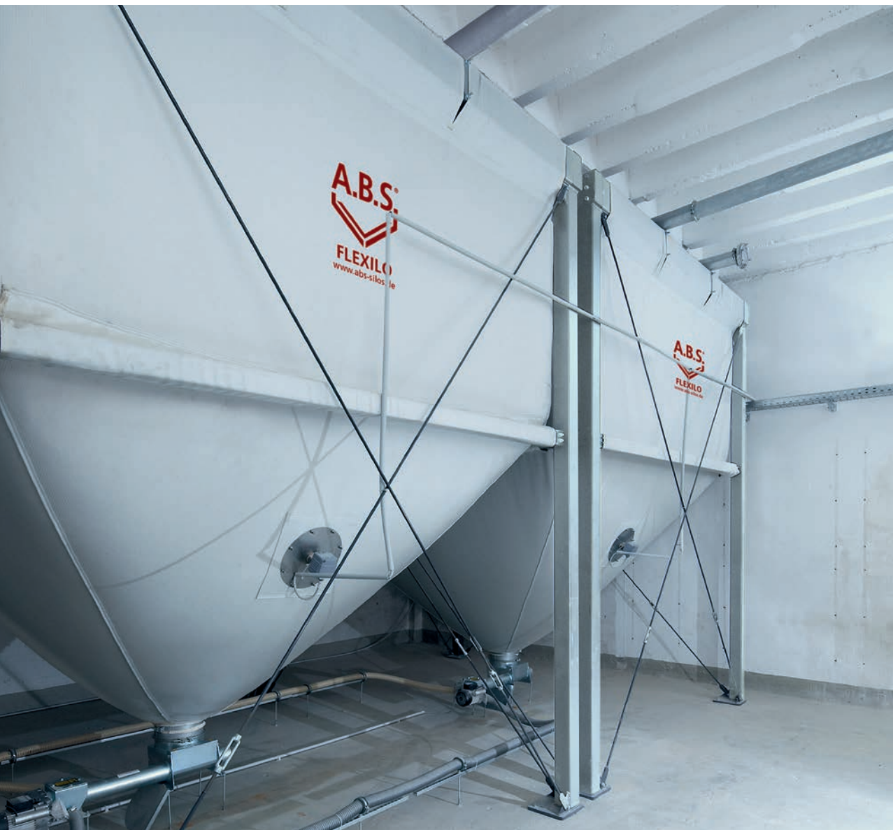
Stockage en cascade du Flexilo MAXI (30 t) pour une chaudière à granulés de bois (100 kW) dans un lycée
